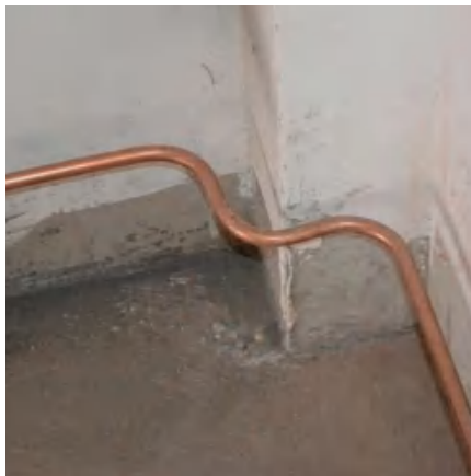
Equipotential grounding conductor
